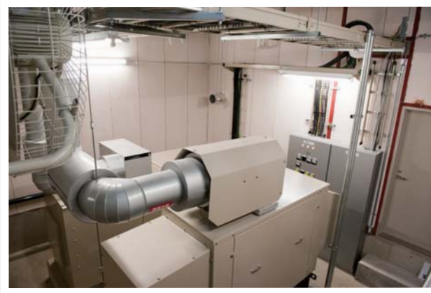
非常用発電装置
