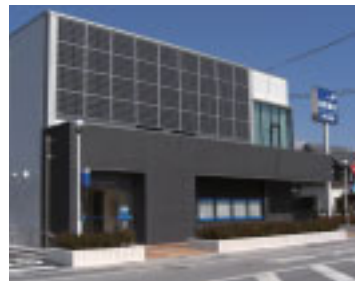
太陽光パネルを設置した山東支店
