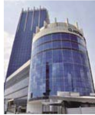
バンコク駐在員事務所が入居するビル
