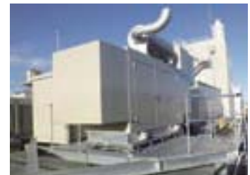
非常用発電装置
