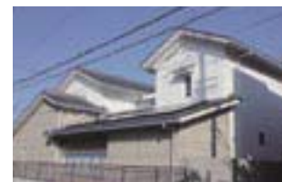
屋根に太陽光パネルを設置した高島支店
