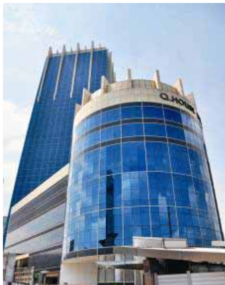
（滋賀銀行バンコク駐在員事務所の入居するオフィスビル）
