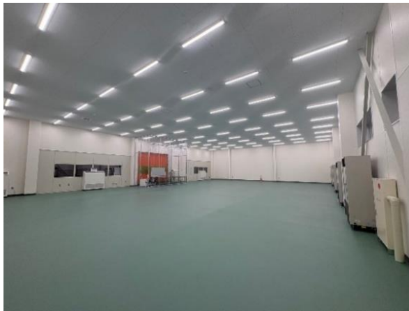
■新倉庫に設置されたクリーンルーム
